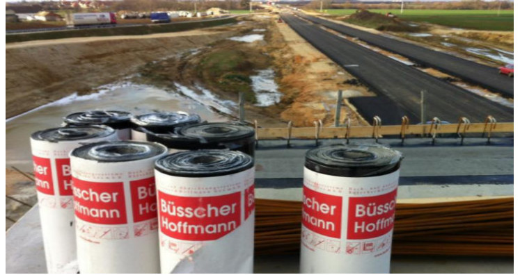
M35 hídszigetelés HÍD-2 rendszerrel
