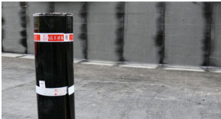
Apartmanház pincészigetelése, Sárvár
