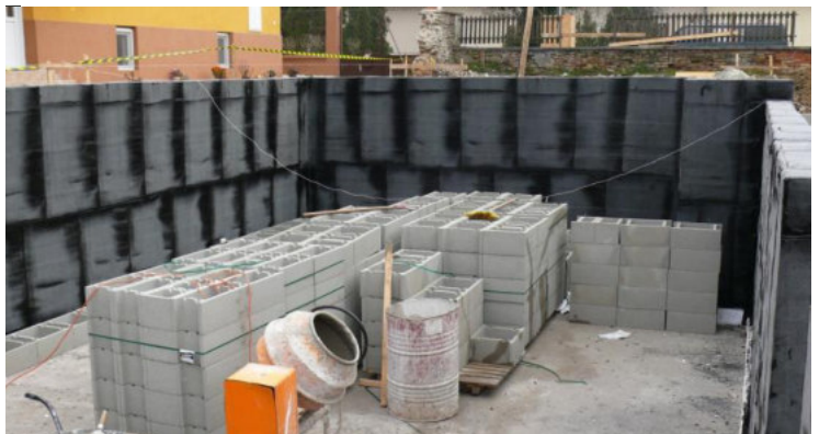
Apartmanház pincészigetelése, Sárvár
