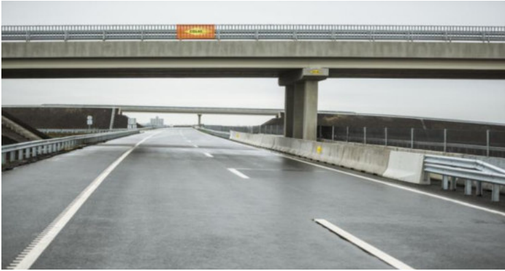
M86 hídszigetelés HÍD-2 rendszerrel
