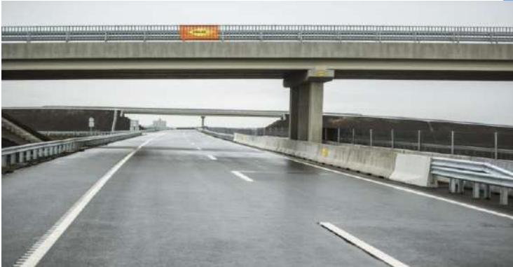
M86 hídszigetelés HÍD-2 rendszerrel
