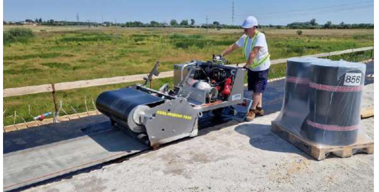
M3 hídszigetelés jumbo terekcsekkel
