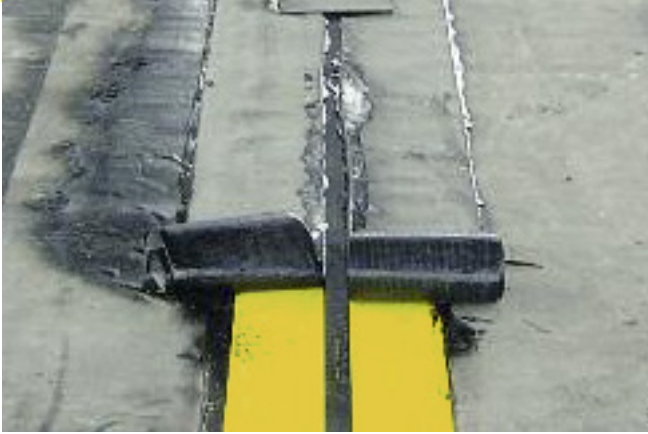
Planebener Einbau (keine störenden Schlaufen und Wülste)
